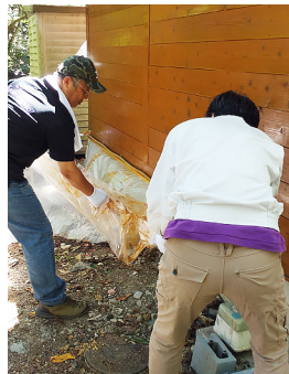
外壁塗装の様子です
