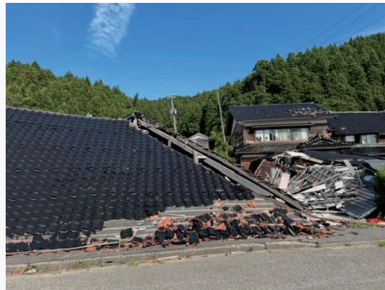
倒壊したままの家屋
